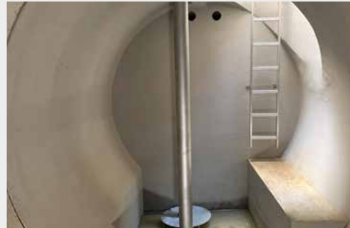
Steigleiter und Auftritt im Tangentialschacht
