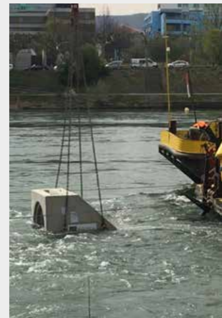
Einlaufbauwerk, Montage unter Wasser
