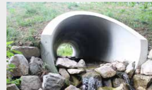
Bachdurchlass mit eingebauten Schwellen
