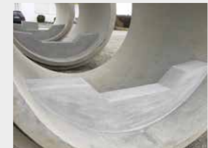
Bachdurchlass mit eingebauten Schwellen
