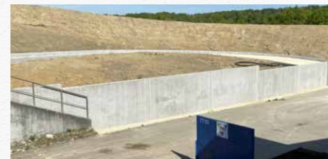
Stützwände für Hangabfang
