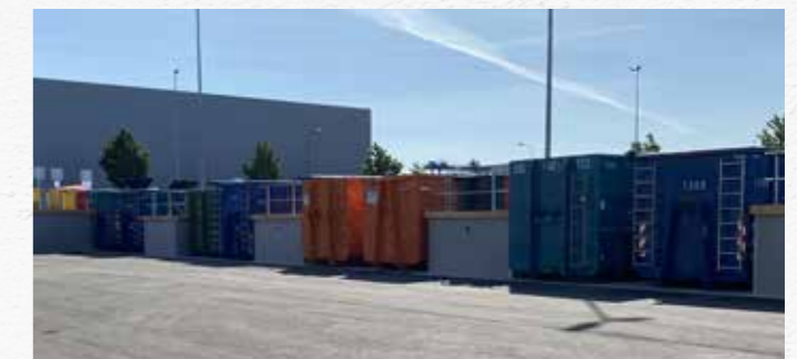
Stützwände für Containerumschlagplatz inkl. Bohrung für Wasserdurchlass
