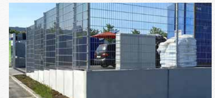
Stützwände als Betriebszufahrt
