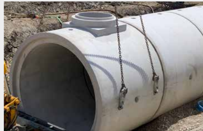
Tangentialschacht mit zentrischem Einstieg
