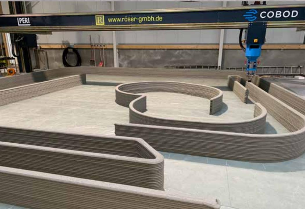
Sehen Sie hier die Entstehung eines 3D gedruckten Fertigteiles – von der Planung, über die Produktion, bis zur Montage auf der Baustelle.
